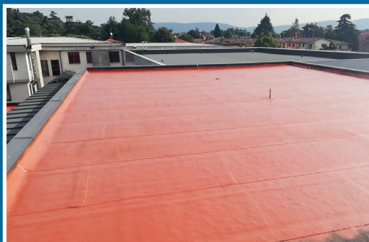
Impermeabilizzazione tetto della scuola media
